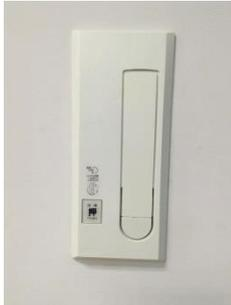
緊急では無い場合には左図の「押」ボタンを一度強く押すと連動して窓が開きます。窓を閉める場合にはレバーを回して閉めてください
